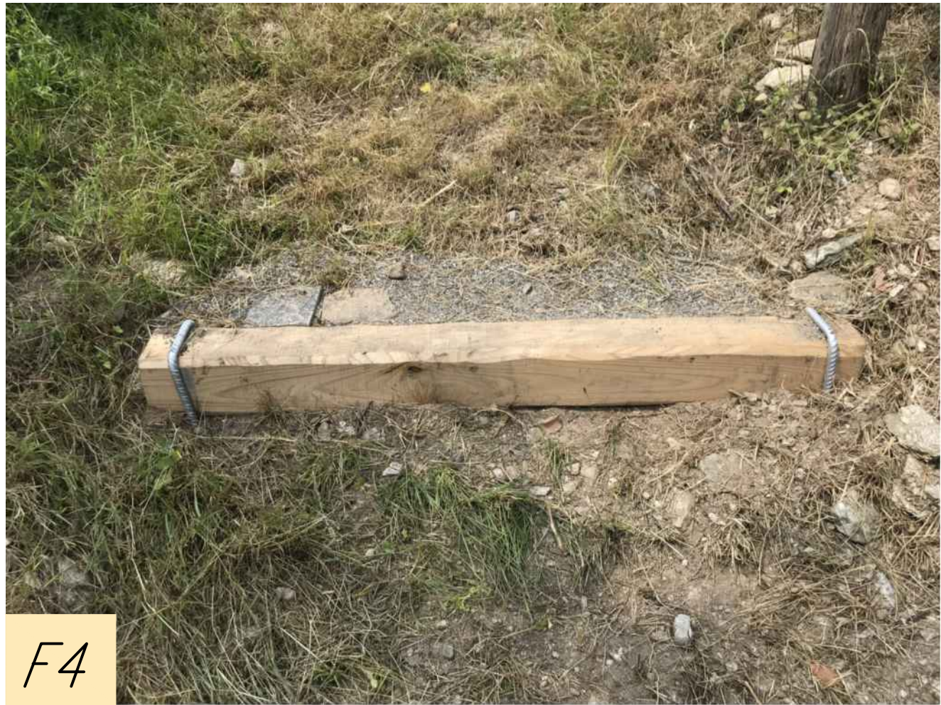
Foto di esempio di realizzazione della gradonata (F4, F5, F6)
